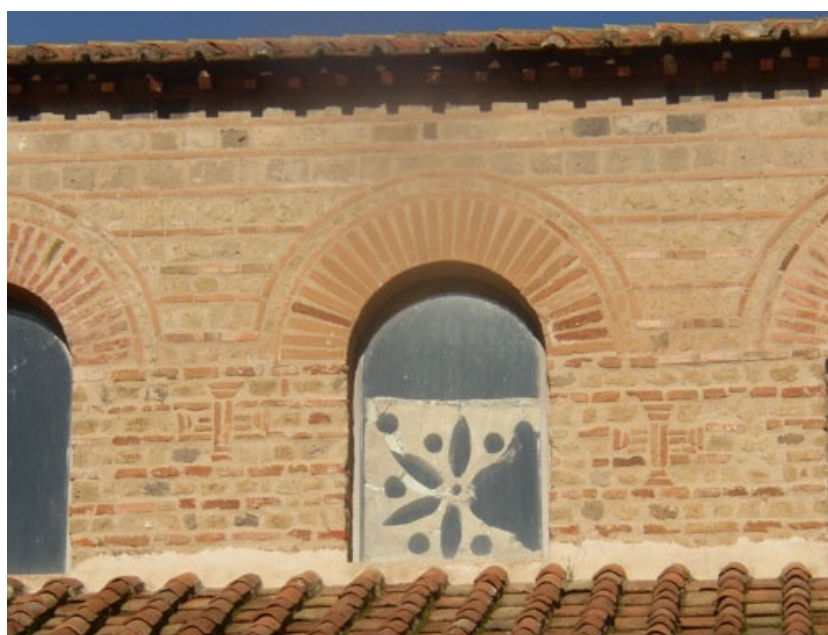
Figura 2. Alvignano, San Ferdinando, particolare della muratura superiore della navata
